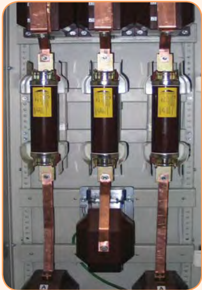
Внутренняя установка предохранителей
