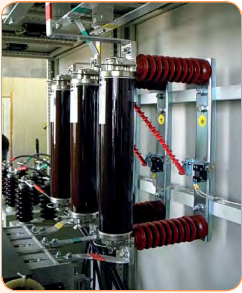
Установка внутренних держателей предохранителей*
